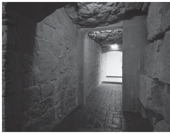
Fig. 22 Pasillo excavado en la muralla del primer piso de la calle Avinyó, 17-19. A la izquierda de la imagen, paramento externo augusteo ( opus certum ); a la derecha, parte posterior del paramento de la muralla bajoimperial ( opus quadratum ). (Foto: MUHBA.)
