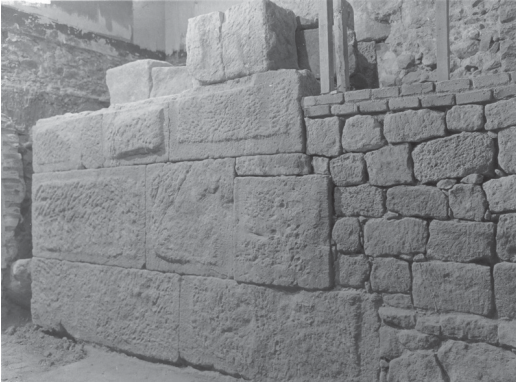
Fig. 23 Paramento combinado de opus quadratum y opus certum . Interior de la puerta NO, en la plaza Nova. (Foto: MUHBA.)
