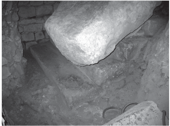
Fig. 24 Cuerpo de la escalera de acceso al paso de ronda. Se observa la técnica constructiva en opus certum : (A) estribo posterior, (B) primeros escalones. (Foto: F. Puig.)
