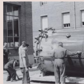
Instal·lació d'un acumulador de la sala de calderes a Can Fabra, c. 1950. Arxiu Fabra i Coats-MUHBA
