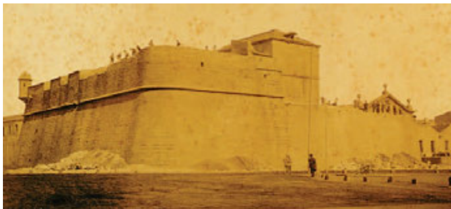
Enderroc del baluard del Rei, a les Drassanes, ca. 1854. © (AFB) Autor desconegut
