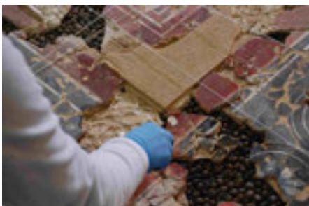
Morter de reintegració de calç hidràulica NHL3 amb marbre triturat i sorra de riu (1:2:1).(©Àbac-MUHBA)
