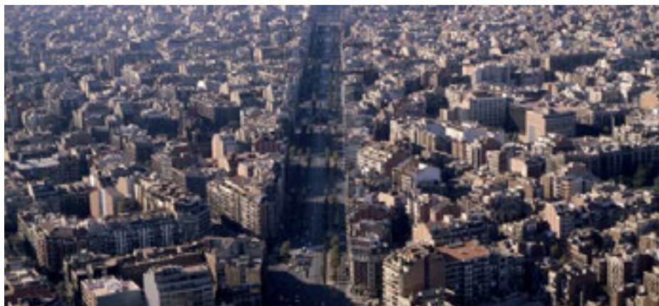
Vista aèria de l'Avinguda Diagonal, 1988. © Arxiu Fotogràfic de Barcelona ( AFB). Autor desconegut
