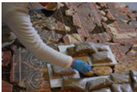
El morter de reintegració és de calç hidràulica NHL3 amb marbre triturat i sorra de riu (1:2:1).(©Àbac-MUHBA)
