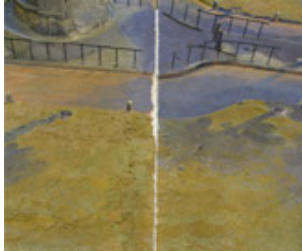
Per a la reintegració de juntes i esquerdes es realitza un estudi previ per a la determinació del material compatible amb els originals i reversible. (©RosaPrat-MUHBA).
