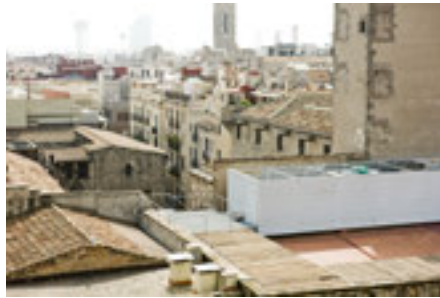
Els edificis protegeixen les col·leccions. Se n'inspeccionen regularment les cobertes i els sistemes de desguàs. Inspecció del terrat del Saló del Tinell.
