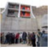
Exterior del Refugi 307
