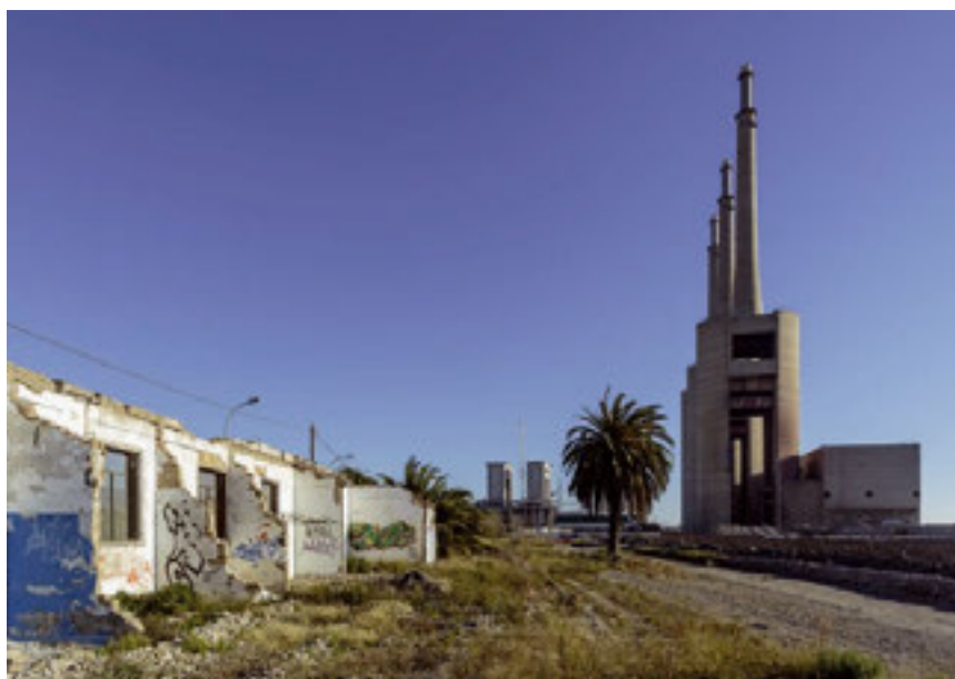
La central tèrmica de Sant Adrià de Besòs ©Christopher Willan, 2016.
