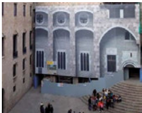
La lona que revesteix la bastida durant els treballs de restauració reproduceix la imatge de la façana. © MUHBA, Josep Bracons
