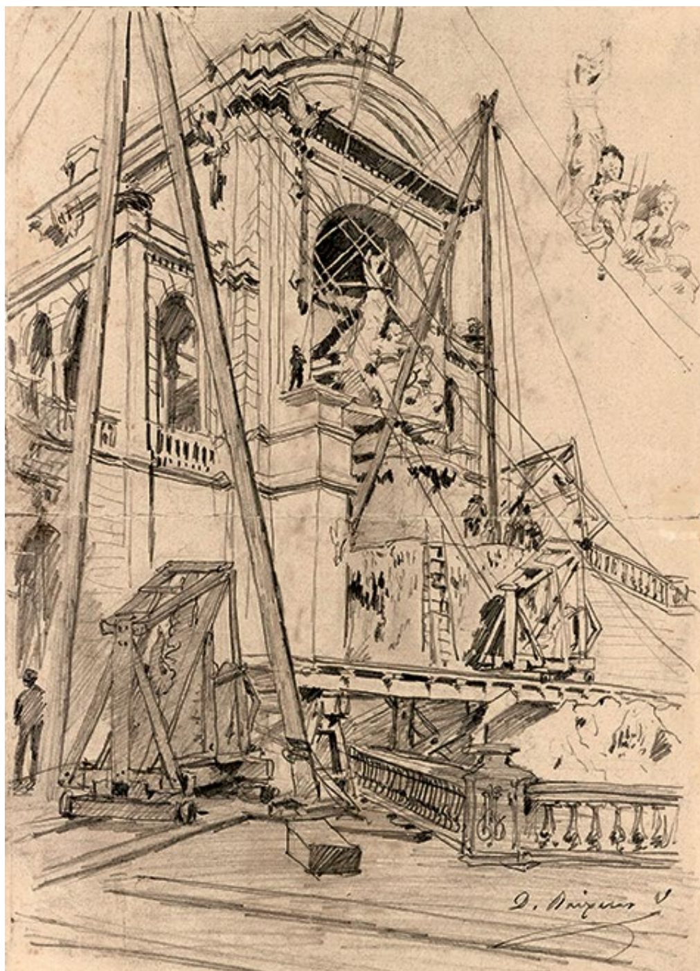
Construcció de la cascada del Parc de la Ciutadella. Dibuix de Dionís Baixeras, 1880. AHCB
