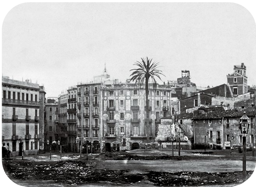
Plaça de Jonquieres, final del recorregut del carrer de Bilbao, primera i única aplicació de la reforma interior sota l'autoritat de Cerdà. Fotografia de Joan Martí, 1874. AFB
