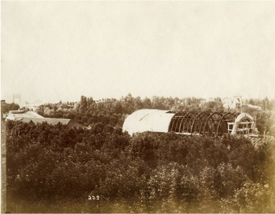
L'Umbracle del Parc de la Ciutadella en construcció el 1887-1888. Fotografia d'Antoni Esplugas. AFB
