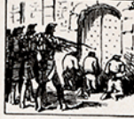
9. Tres dels mal intencionats a la rambla afusellats.
