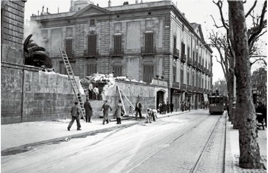
El palau Moja durant la demolició de la tanca del jardí per construir-hi l'edifici baix que allotjaria un gran establiment comercial (1934). AFB
