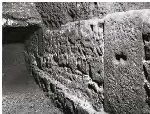
Figura 48. Mur adossat perpendicularment a la muralla en el subsol del palau Requesens. 18
