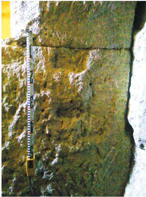
Figura 55. Negatiu d'una frontissa en el pilar D3.
