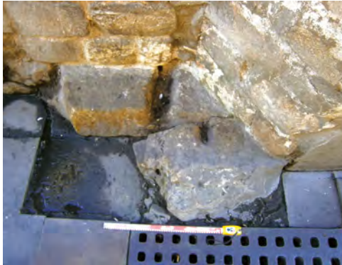
Figura 26. Sortint en forma de L del pilar meridional del pas septentrional del pas central.
