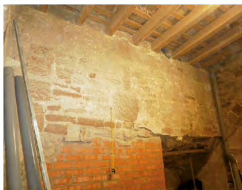
Figura 76. Trams de l'obra baix-imperial amb opus africanum , localitzats al palau Episcopal (a), al Pati d'en Llimona (b, c) i a l'interior del carrer de Lledó (d).
