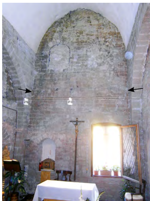
Figura 93. Interior de la torre D/III/4 (torre 74 segons la numeració tradicional), façana del nord-oest. Amb les fletxes s'indica la filada de parament que sostenia el paviment del segon pis.
