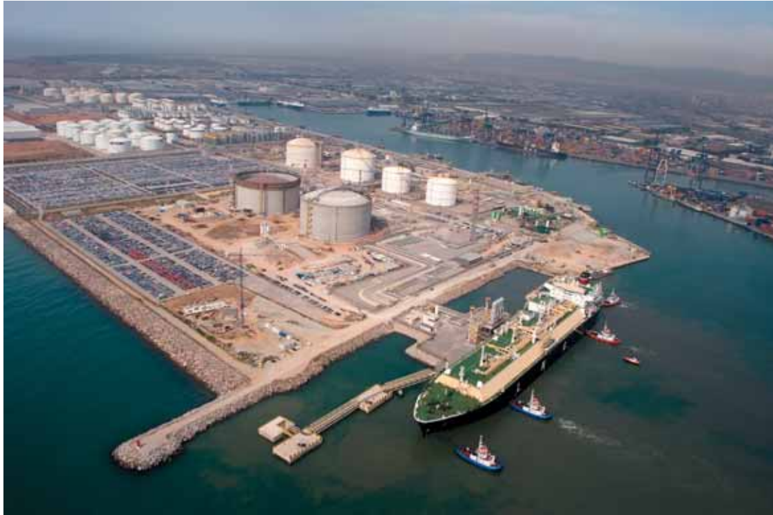
Moll d'Inflamables del port de Barcelona, on es troba la planta regasificadora de gas natural. El Pla de Millora Energètica de Barcelona preveu aprofitar el fred residual per a climatització, un cop distribuït a través d'una xarxa de districte. A les pàgines anteriors, la central de producció d'aigua calenta i freda del Fòrum i obres de la xarxa de distribució a l'àrea del 22@.
