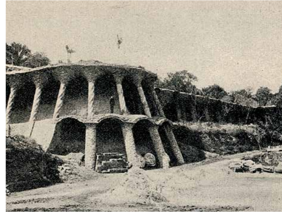
Doble pòrtic darrere la Casa Larrard en construcció, 1903. Imatge extreta de Salvador SELLES [i BARÓ], «Park Güell», dins Anuario para 1903 , Asociación de Arquitectos de Cataluña, pàg. 58. AHCB
