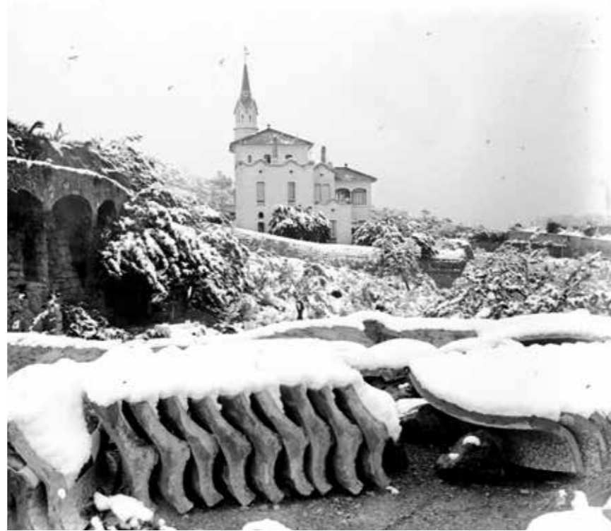
Casa dels Gaudí o casa mostra. En primer terme s'aprecien les peces prefabricades per al banc ondulat del Teatre Grec, 1910. Càtedra Gaudí
