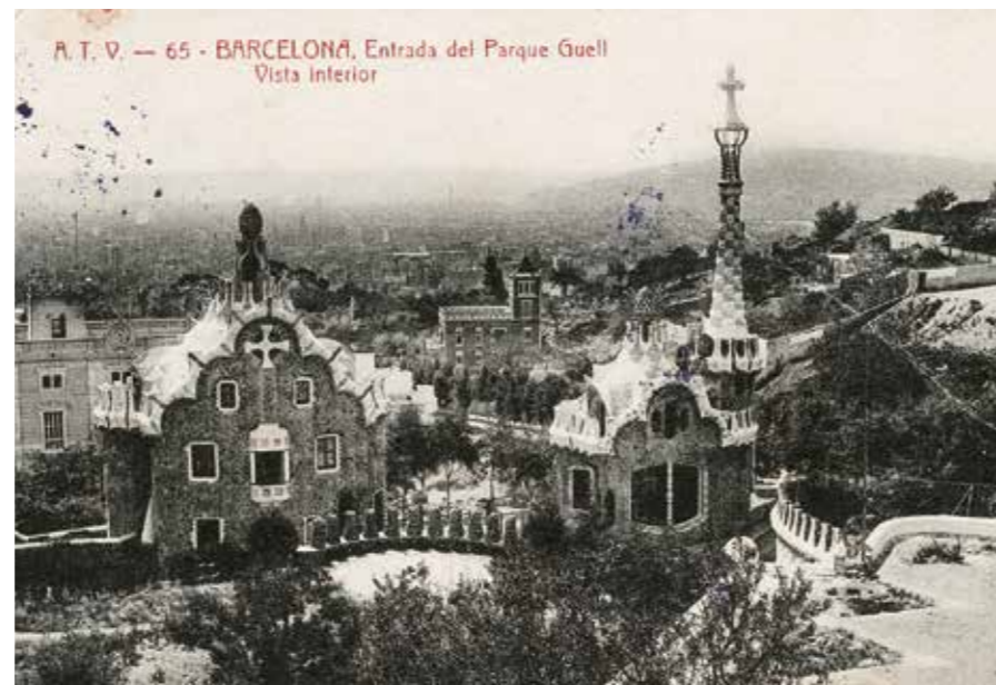
Vista interior de l'entrada en el moment en què s'està iniciant la construcció de la Sala Hipòstila, les traces de les columnes estan marcades al terra, 1905, Àngel Toldrà Viazó. Col·lecció Juan José Lahuerta
