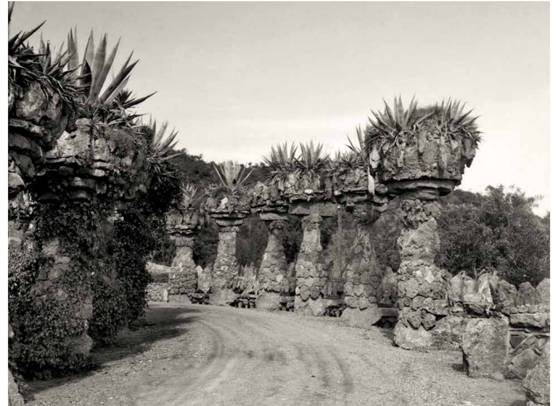
Atzavares en els testos del Pont de Dalt del Park Güell, 1910-1929, Esteve Puig. AFB
