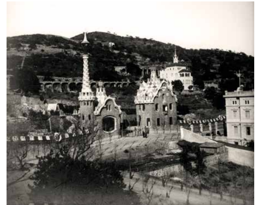
Vista del Park Güell, on només es veu construïda la casa mostra, la dels Gaudí. Fons Canosa. Càtedra Gaudí
