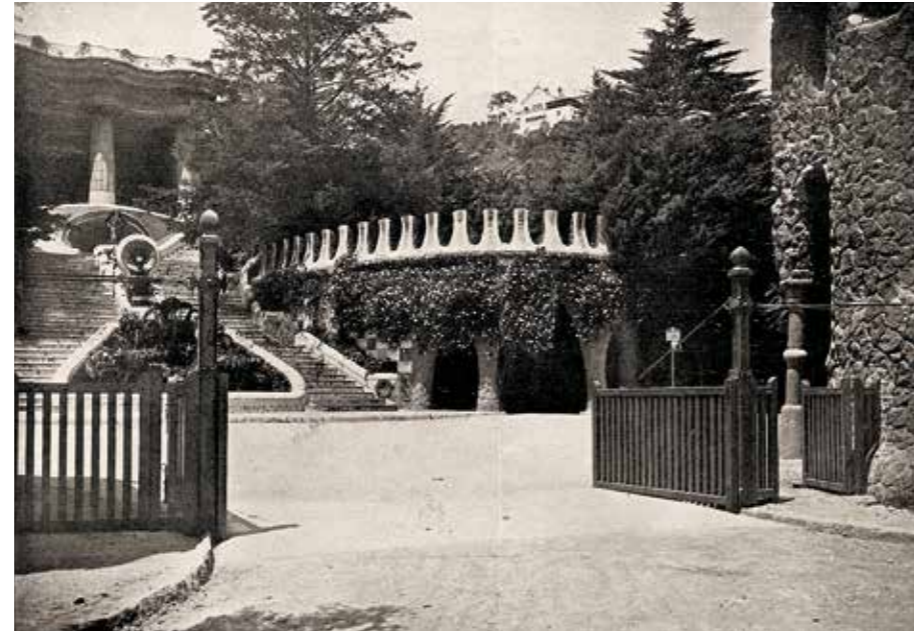
Segona porta de l'entrada principal, 1926, Carlos Pérez de Rozas Masdeu. Imatge extreta de Barcelona Atracción , xvi, 182 (agost de 1926), pàg. 5. AHCB
