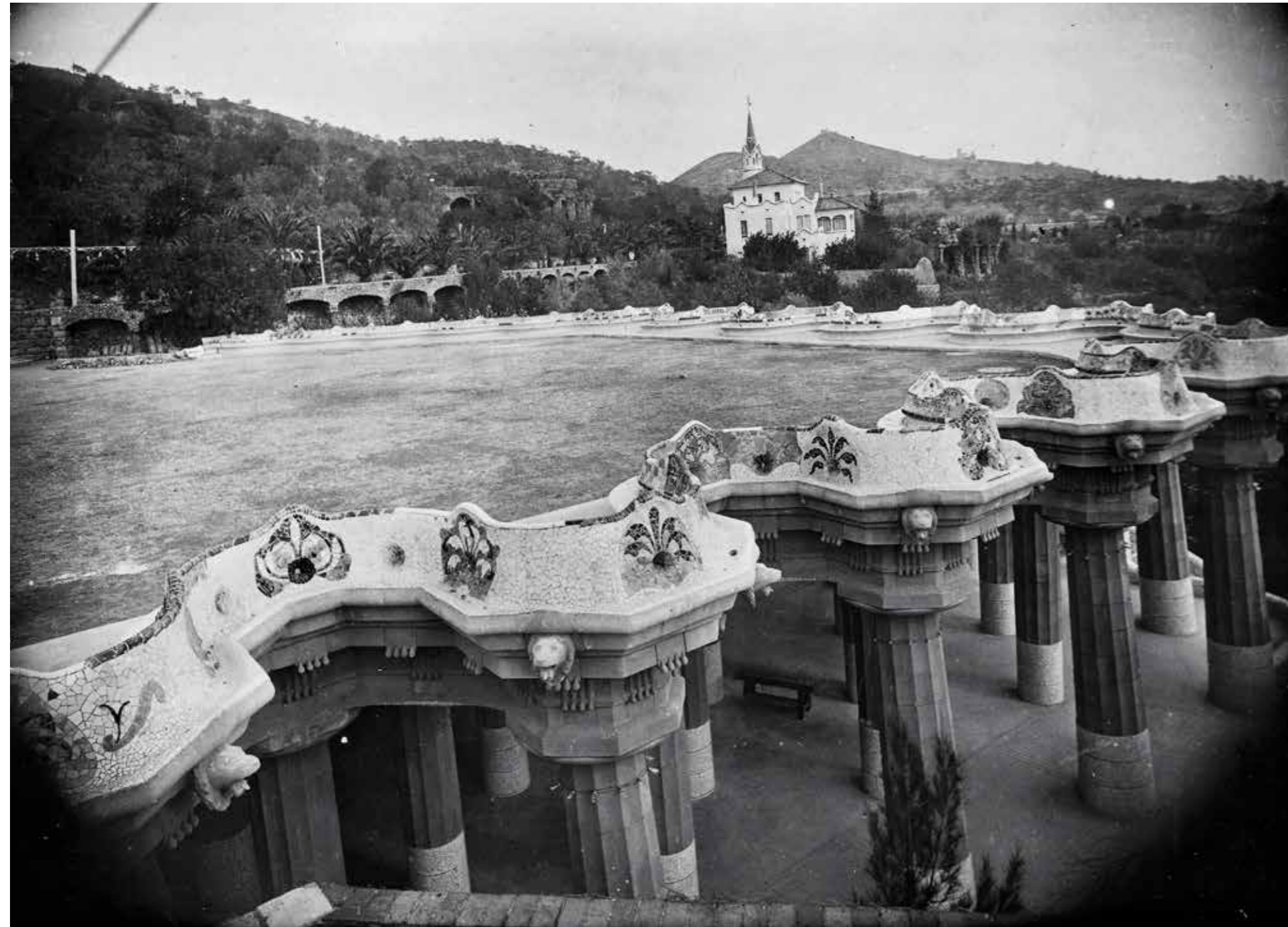
Vista de l'esplanada o Teatre Grec, al fons es veu que només falta acabar el banc a l'extrem nord, c. 1914. Jorge Venini. AFB
