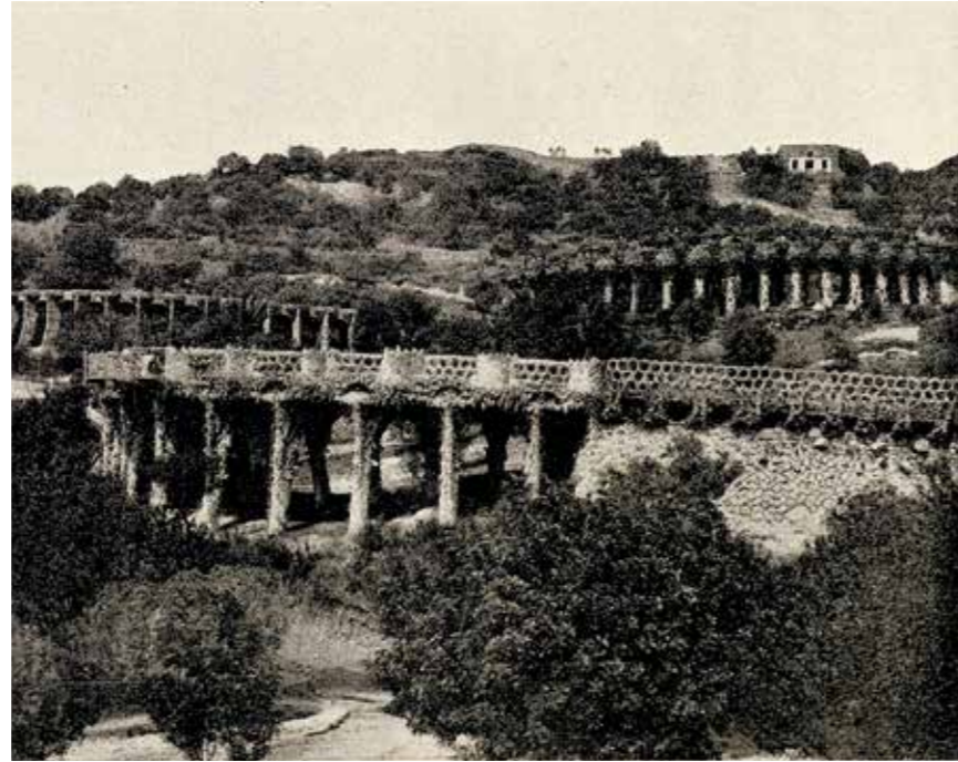
Vista general dels viaductes, 1903. Imatge extreta de Salvador SELLES [i BARÓ], «Park Güell», Asociación de Arquitectos de Cataluña. Anuario para 1903 , pàg. 53. AHCB
