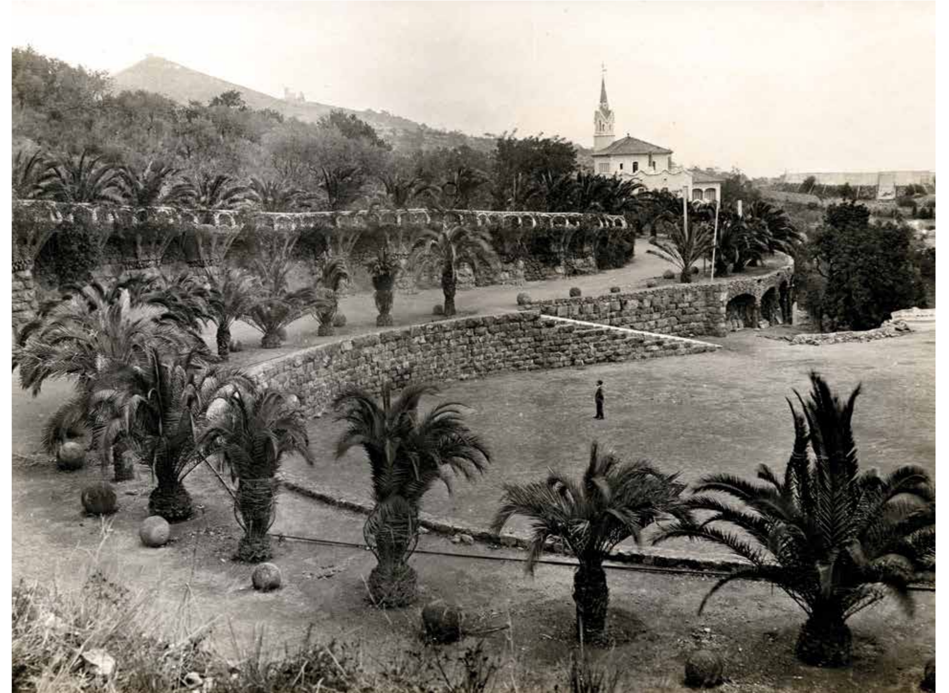
Murs de contenció de l'esplanada i del passeig central, 1915-1925. Jorge Venini. AFB
