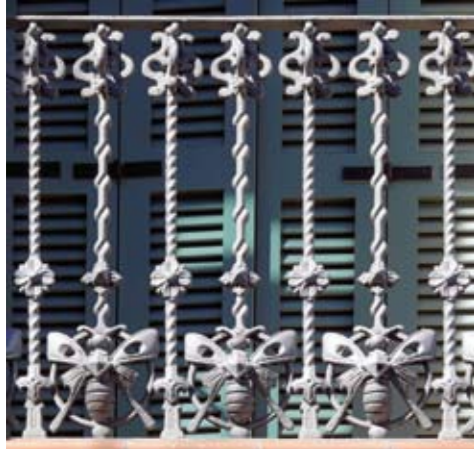
11. Detall de la barana de la façana de M. Comas i Thos, casa Emili Marfà i Artigas, carrer d'Ali Bei, 29, 1900
