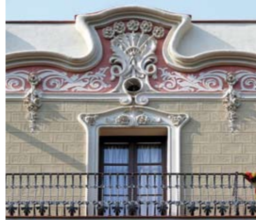
13. Detall del darrer pis de la casa del carrer de la Diputació, 369
